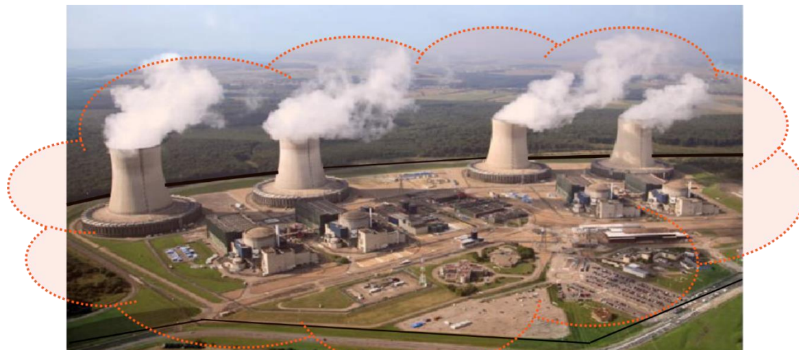
Couverture LTE/4G : Intérieur Bâtiment réacteur - Bâtiments industriels tranche X - Tranche 0 Extérieur + 5 km
