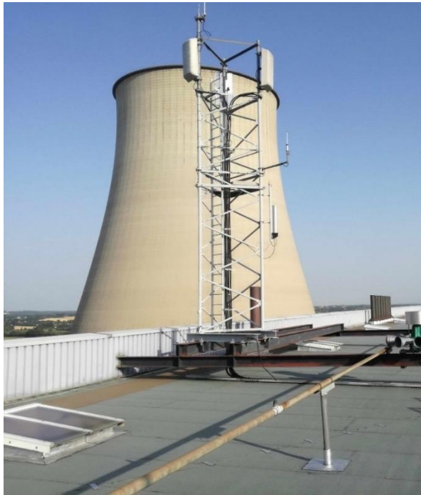
Pylône sur toiture 10m Type BELLEVILLE
