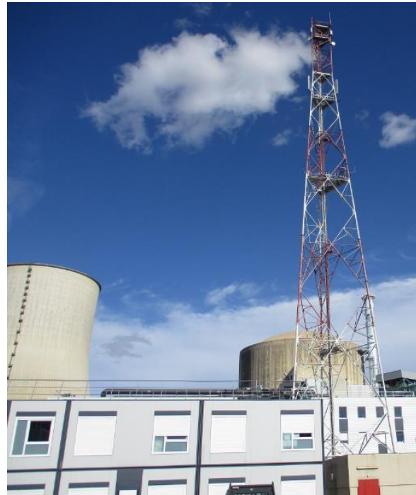
Pylône au sol 30 à 60m Type CIVAUX
